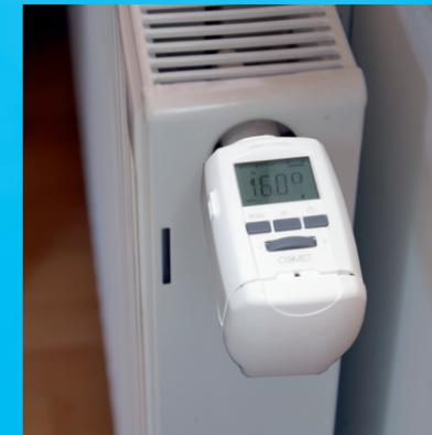
lichen Thermostat-Regler zeigen mit der Zeit Verschleißerscheinungen und werden ungenau; deswegen sollten sie nach 15 Jahren ausgewechselt werden.
